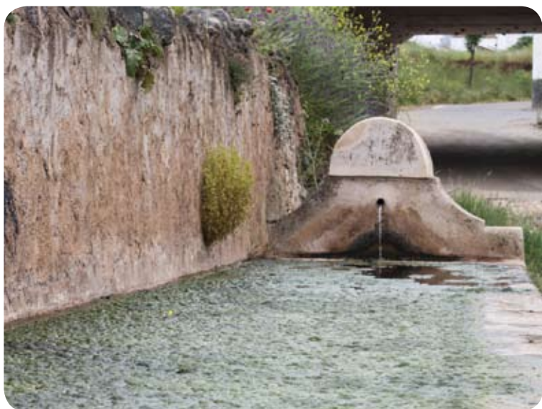
Abrevadero al inicio de la etapa
