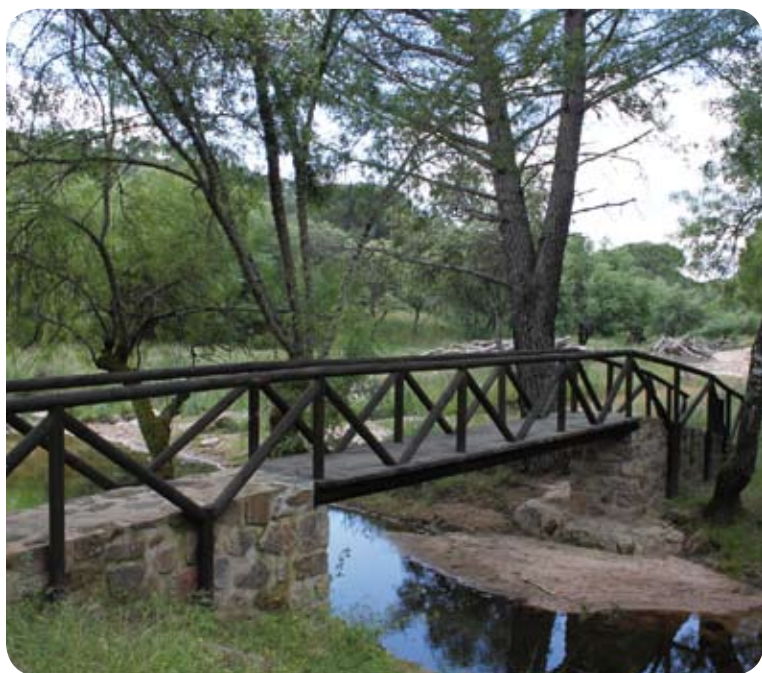
Puente peatonal sobre el arroyo de los Santos
