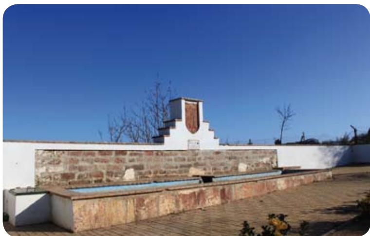
Pilar al inicio de la etapa
